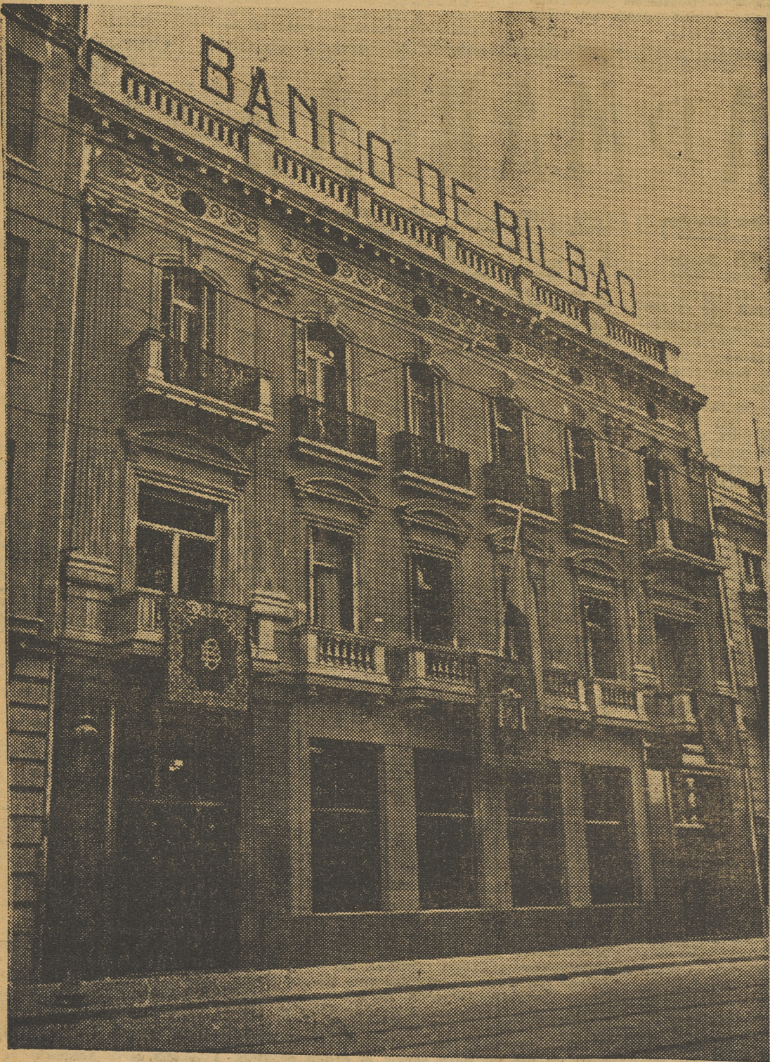
Fachada del edificio propiedad del Banco de Bilbao, en el cual han quedado instaladas sus oficinas
