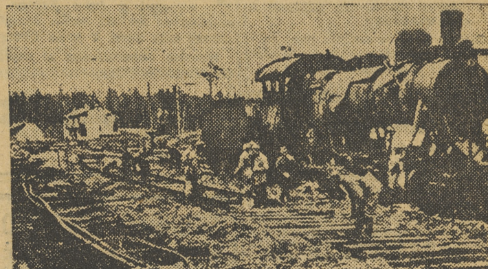
Soldados ferroviarios finlandeses, reparando una vía destruida.—(Foto Vidal)
