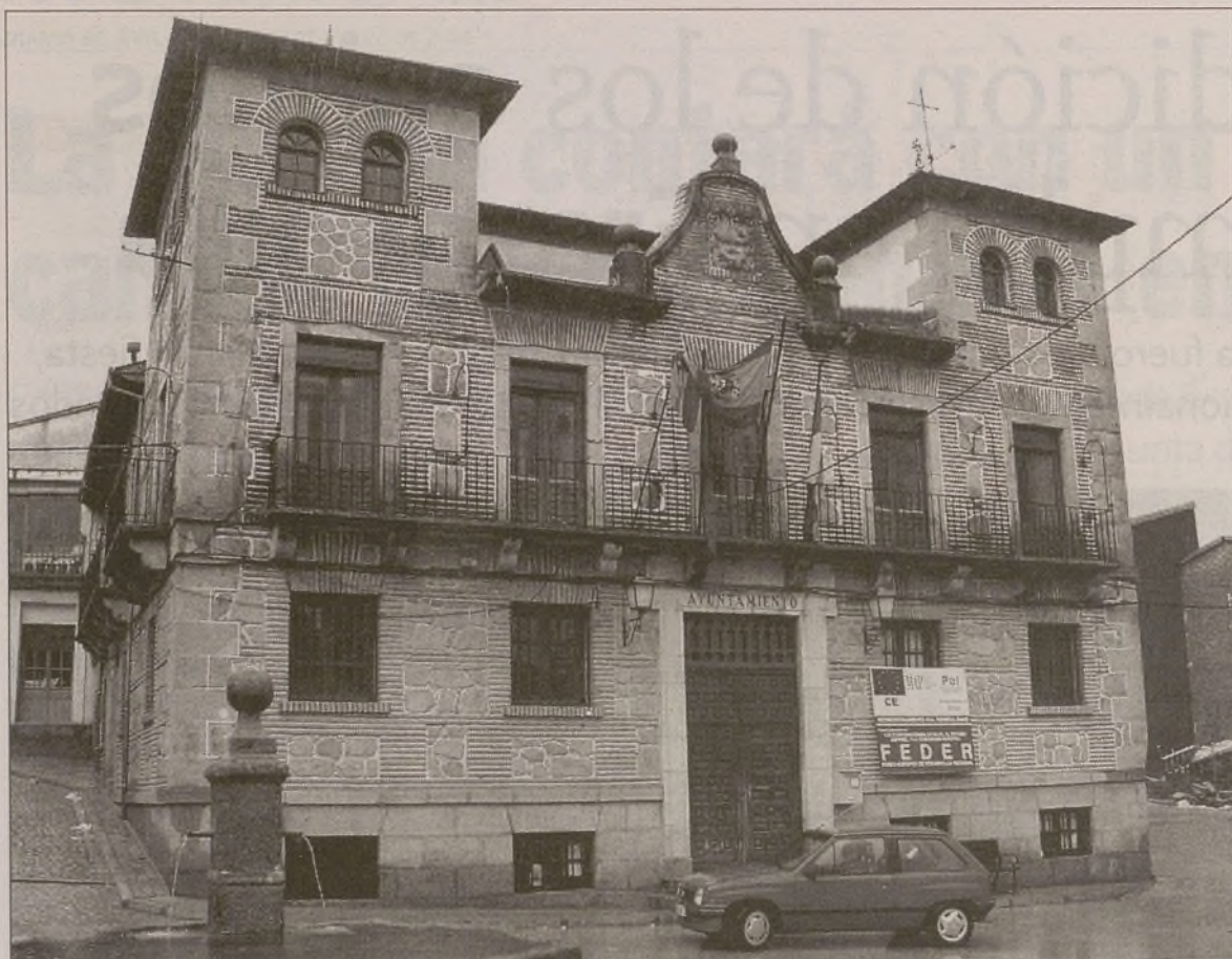
Una imagen de la fachada del Ayuntamiento de la localidad de Mombeltrán.
