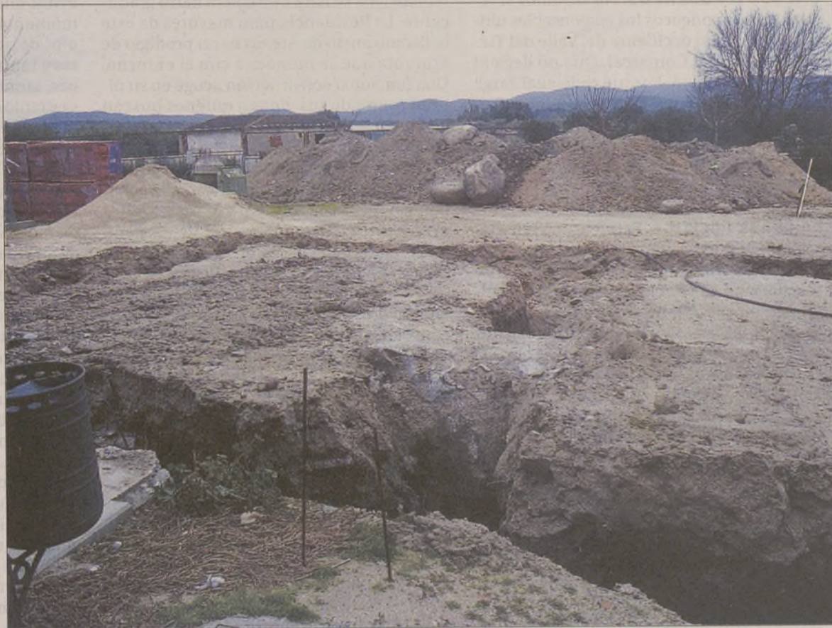
Imagen actual de las obras de ampliación del instituto ubicado en la localidad de Sotillo de la Adrada. / BEATRIZ LORENZO
