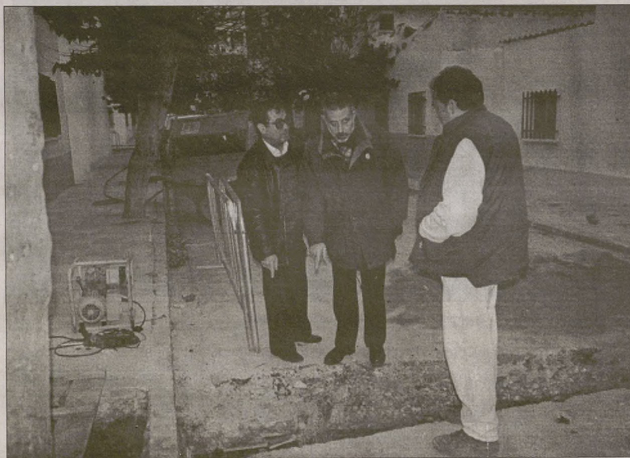
José Manuel Martínez Cenzano visita con regularidad las obras de canalización de gas.
