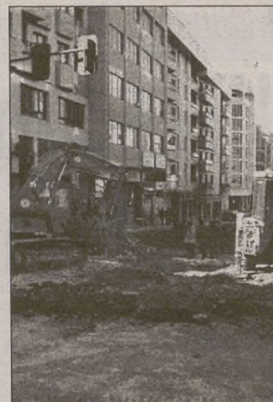
Las obras marchan según lo previsto.
