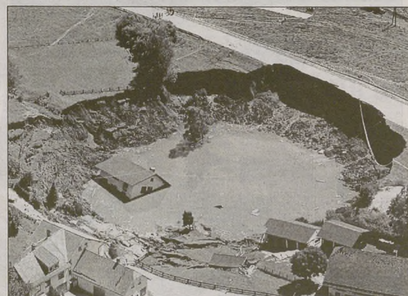
Aspecto de la mina de Austria donde ocurrió el siniestro.
