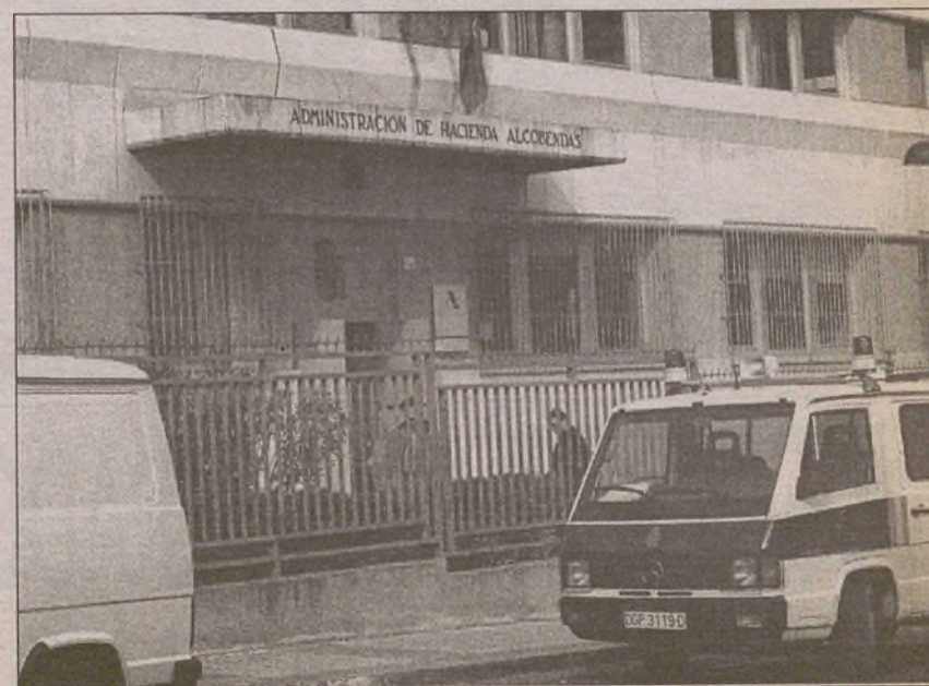
Estado en el que quedó una de las delegaciones atacadas.
