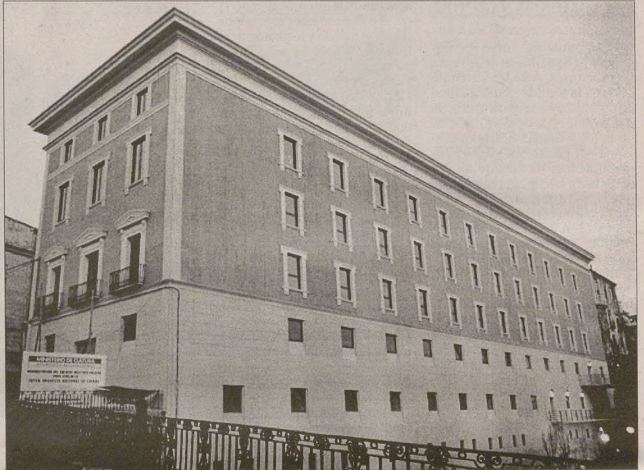
Edificio de la JONDE, ubicado en la calle Palafox de Cuenca.
