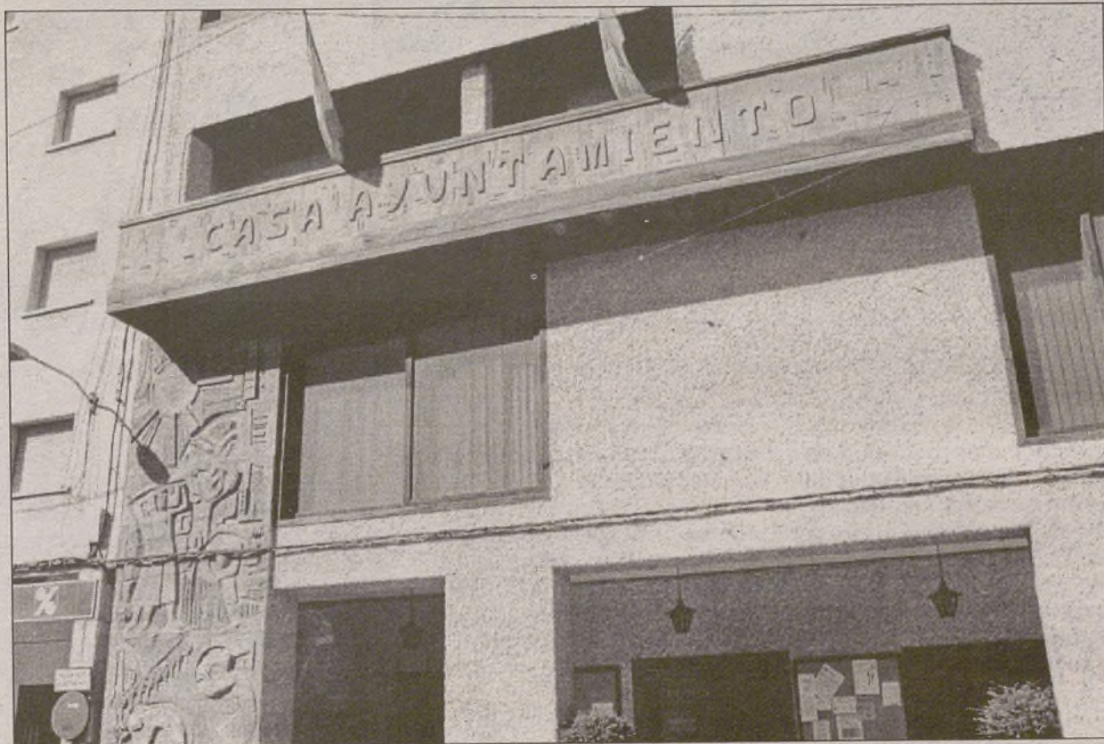
Fachada del Ayuntamiento de Tarancón.
