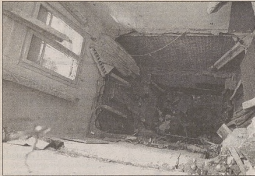
Las tareas de desescombro continuaban ayer.
