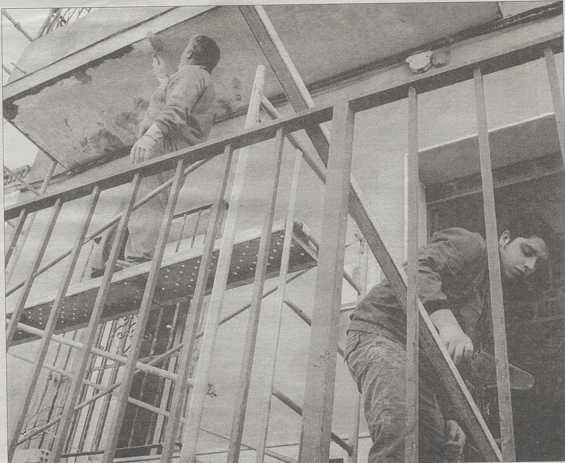
Obreros realizando una reforma.
