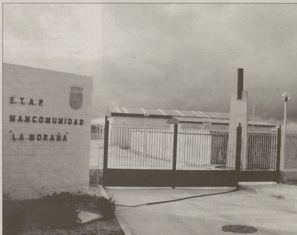
Acceso a la planta potabilizadora ubicada en Arévalo.
