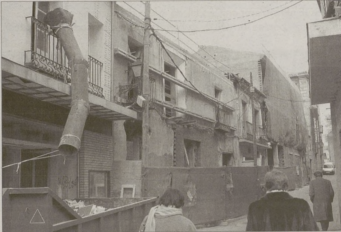
Aspecto actual de la calle Estrada, con varios edificios en reconstrucción. / ENRIQUE LUIS
