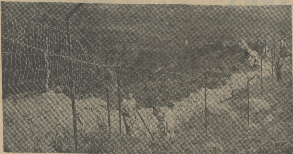
Instalación de la cerca cinegética
