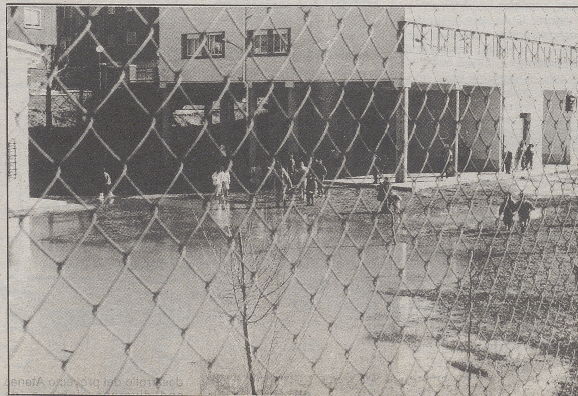
El inconveniente del patio es que se inunda con facilidad.
