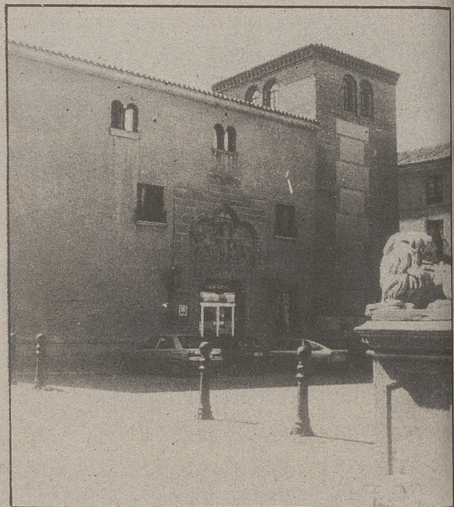
Fachada del Hotel Palacio de Valderrábanos.
