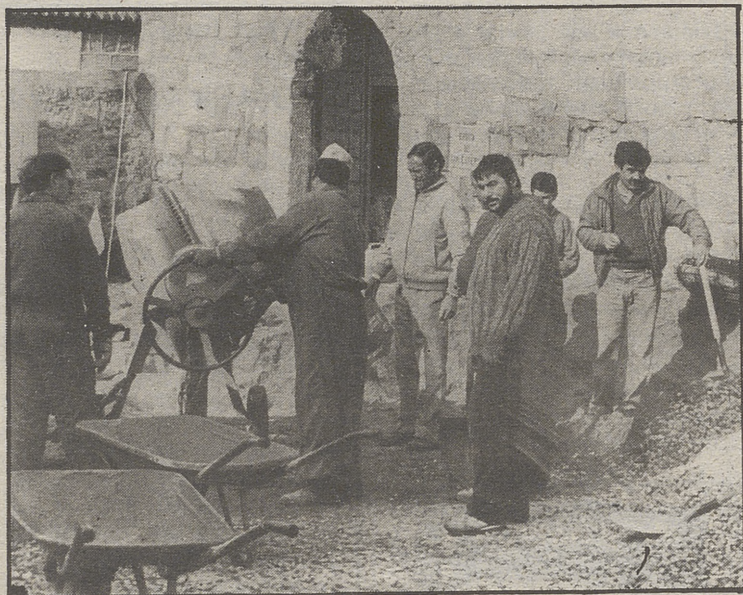
Junto a la ermita se prepara el hormigón.
