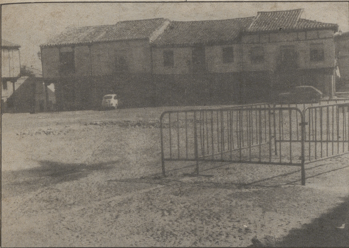
Un aspecto de las obras que se realizan en la Plaza de la Villa
