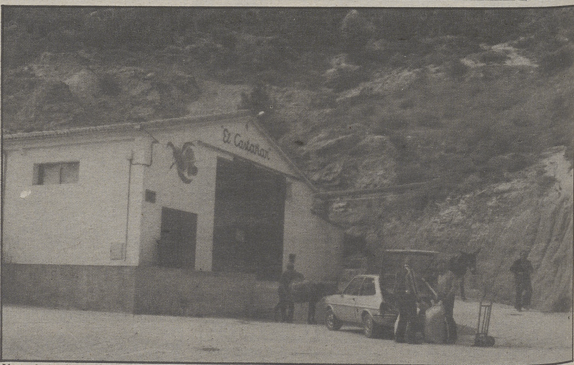
Nave de la Cooperativa El Castañar.
