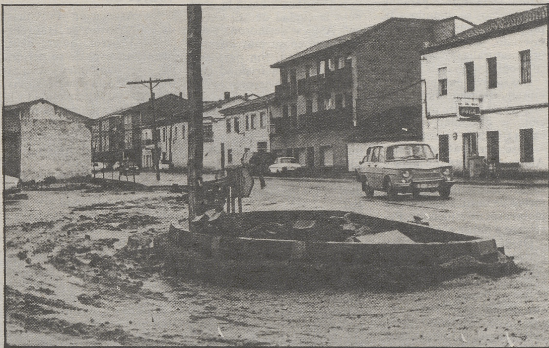
En San Pedro del Arroyo se realizan actualmente obras de pavimentación de calles
