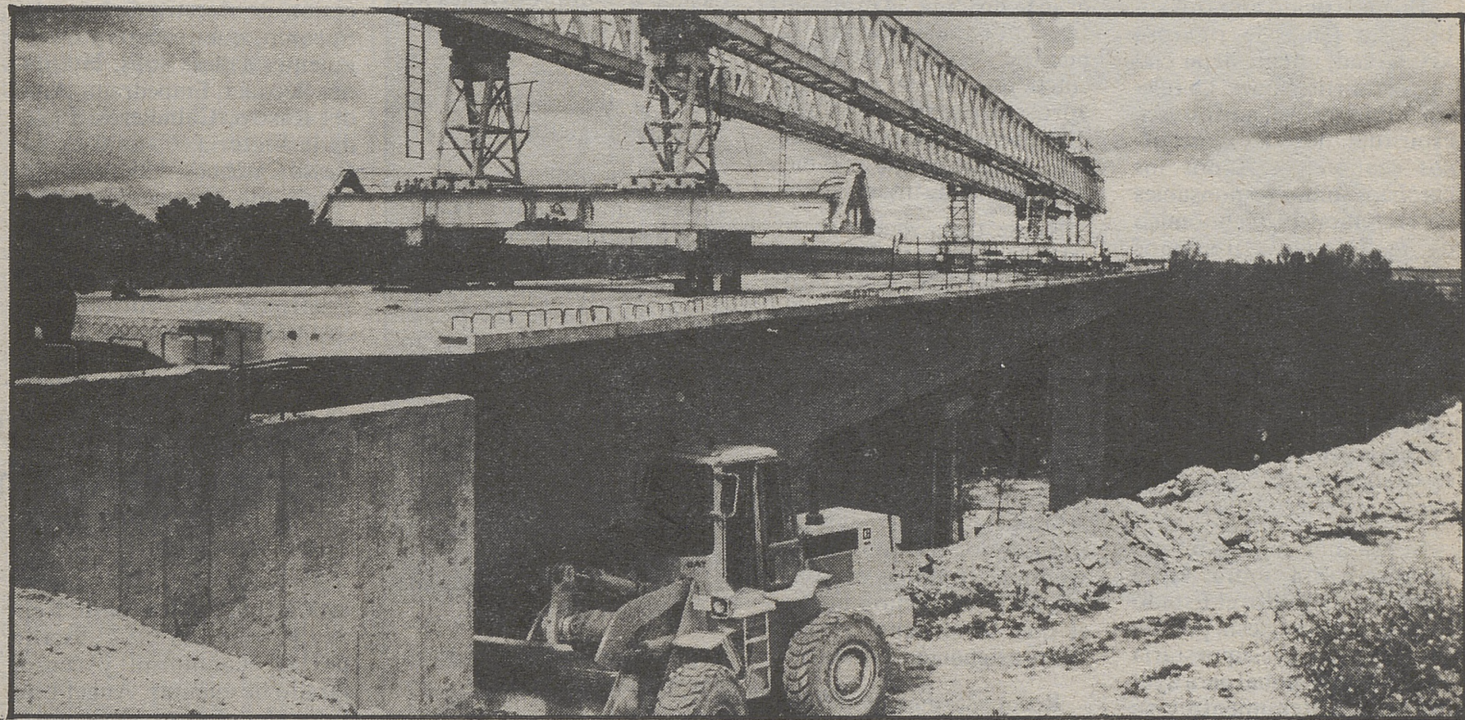
Un puente de casi doscientos metros de longitud y veinticinco de altura máxima, sobre el río Arevalillo
