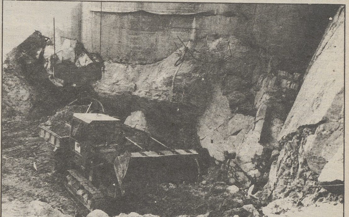
Los trabajos en la falla de la presa de Las Cogotas pueden estar terminados antes de Semana Santa.
