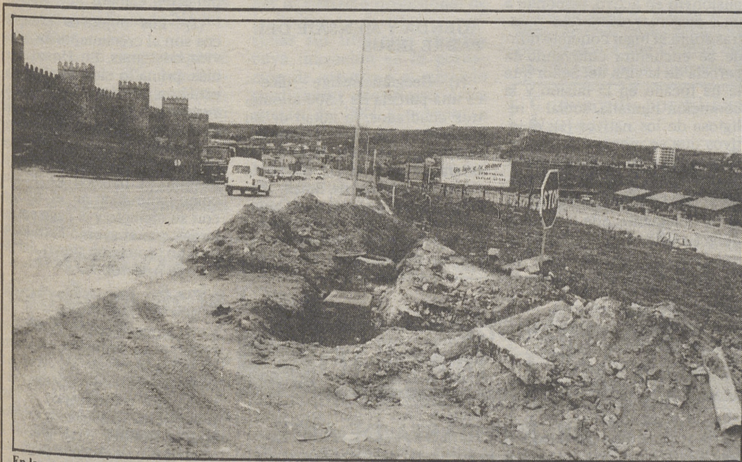
En la zona de La Encarnación se está procediendo a instalar una nueva arteria de agua.
