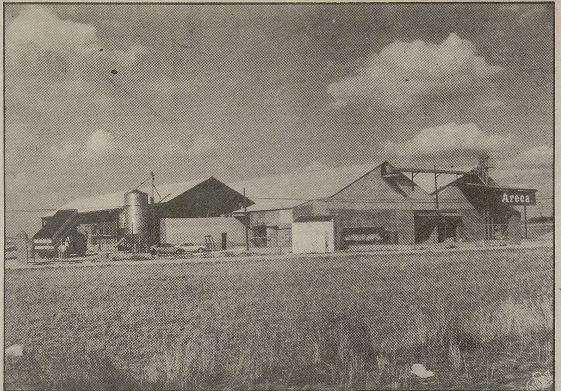
Instalaciones de esta cooperativa.
