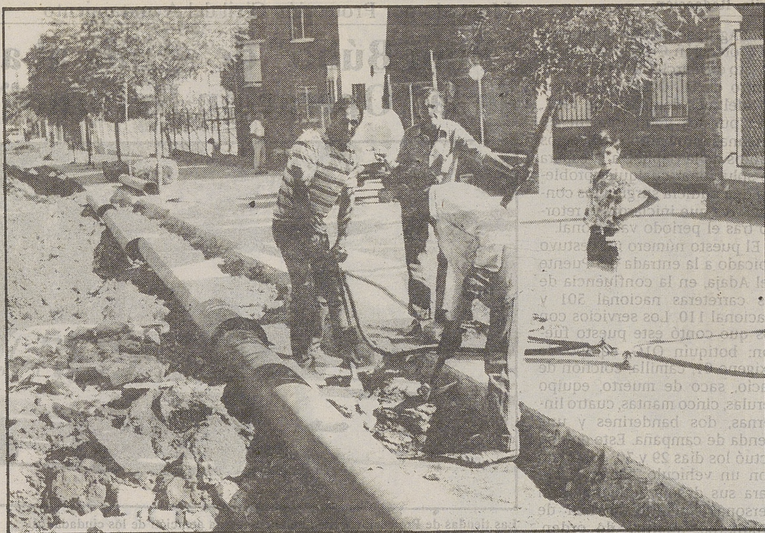
Obras de la nueva arteria de agua
