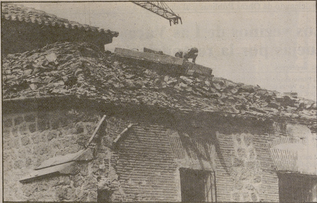
Trabajos en la cubierta de Santa Ana.
