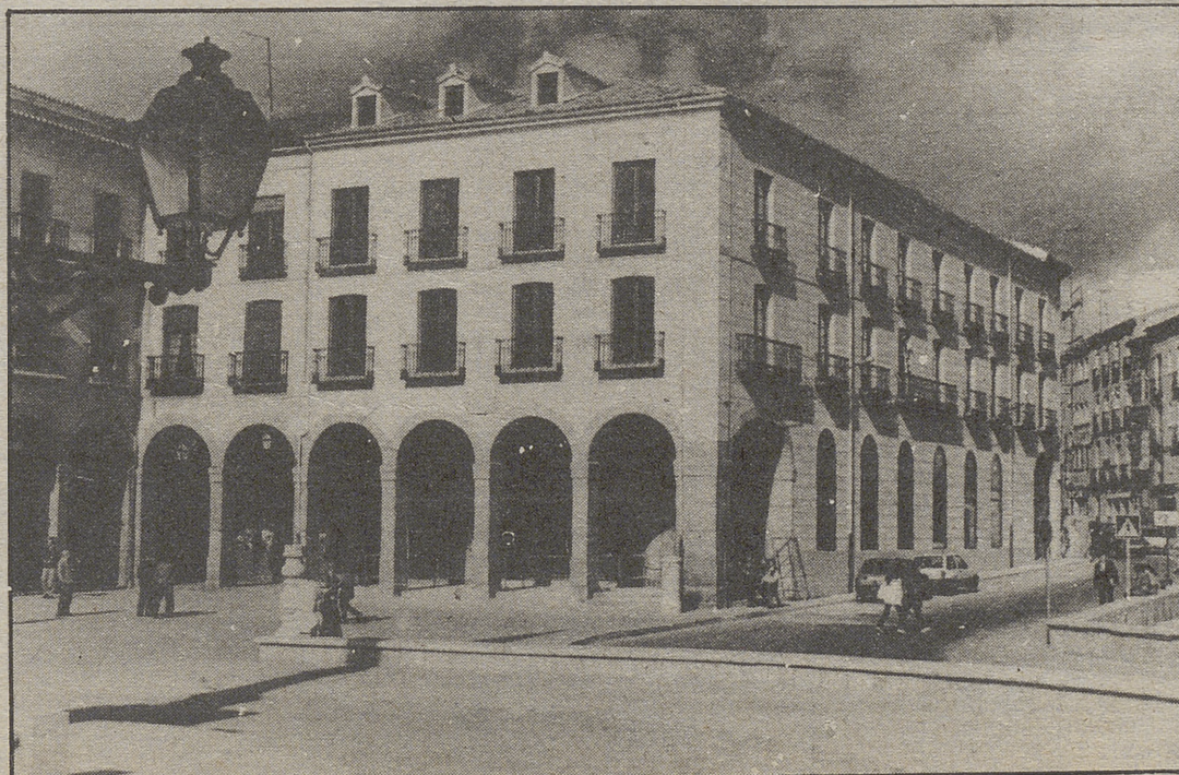
El edificio de la Caja de Ahorros de Avila, en el Mercado Grande, aparece ya libre de vallas. LUMBRERAS
