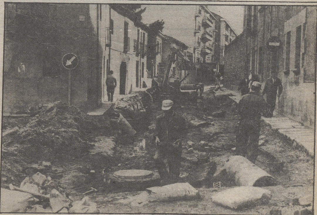
La calle Eduardo Marquina, cortada al tráfico por las obras
