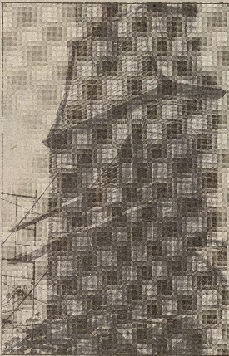
Esta mañana se pagó la licencia de obras correspondiente a la restauración de Santa Ana. LUMBREAS
