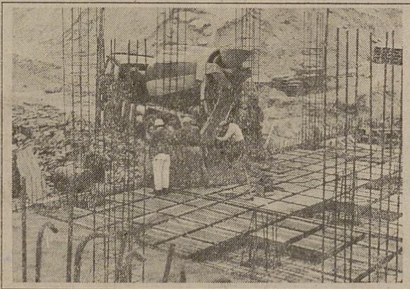
Hacen falta 200.000 m<sup>3</sup> de hormigón para construir unos edificios. Los camiones-hormigonera Pegaso 3.060 GL, de 200 cv., los llevan. La gran solidez de su bastidor, así como la de su eje delantero; el puente posterior, previsto de un sistema de bloqueo a voluntad, mediante un tercer diferencial, permiten a este Pegaso actuar en terrenos difíciles. Con suspensión especial trasera mediante tacos de goma. La servo-dirección, con mando hidráulico, posibilita una conducción más cómoda.
