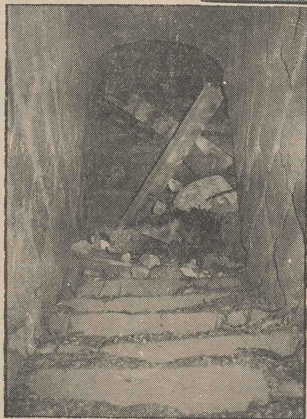
Las diversas fotografías recogen los efectos destructores en muros, bóvedas y campanario. El rayo partió de cuajo bloques de granito de más de dos metros de perímetro.—(Fotos: Mayoral).
