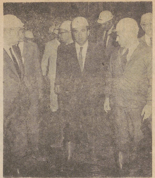
AUTOPISTA VILLALBA-VILLACASTIN. — La foto de Ap-Europa, tomada en el interior del nuevo túnel, muestra la visita que acaba de realizar el ministro de Obras Públicas, don Fernando Fernández de la Mora, a las obras de la autopista Villalba-Villacastin, en la carretera general VI Madrid-La Coruña, hasta el pueblo abulense de Adanero.
