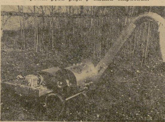
Cilindro trillador "LAGARTO", acoplado a todas máquinas empacadoras.
