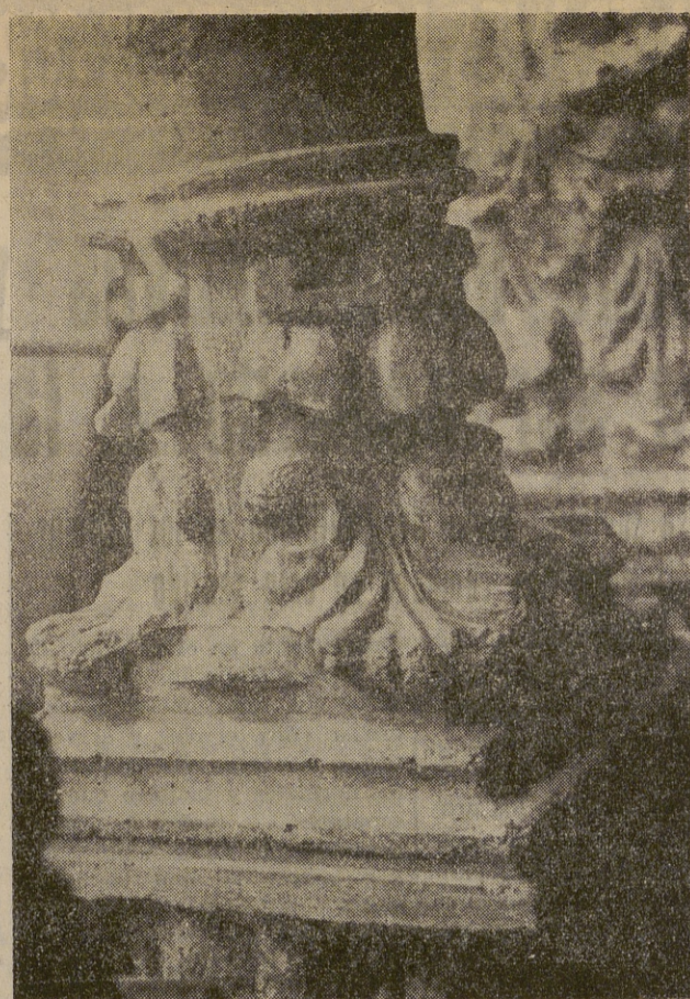
Los capiteles, base de las columnas radiales (alto), moldeados en cemento. Los gemelos, que alternaban entre las columnas y que por formar parte de la circunferencia de Dovelas no han sido tocados, (bajo).
