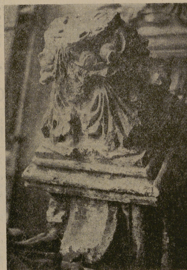
Los capiteles, base de las columnas radiales (alto), moldeados en cemento. Los gemelos, que alternaban entre las columnas y que por formar parte de la circunferencia de Dovelas no han sido tocados, (bajo).
