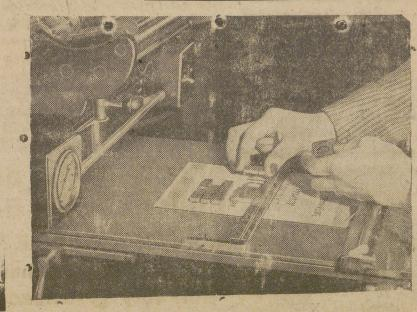
claro y único significado: el por-La nueva máquina para imprimir en colores admite madera, tador de un glorioso nombre con metal, caucho, popeles de todos los grueses, etc., y permite gran variedad de combinaciones
