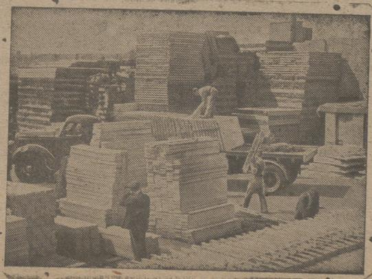
Cargando partes de una casa prefabricada en un camión en la estación de Edmouton, al norte de Londres. Una casa completa es llevada en cada camión.
