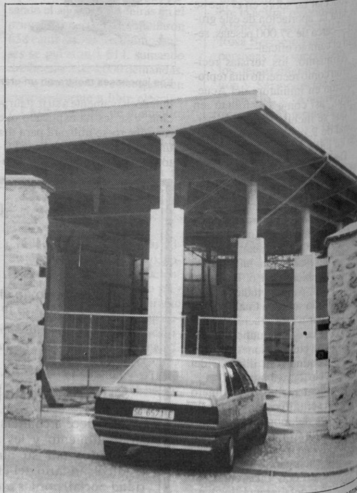
Las obras de la nueva nave para madera se terminará en un año.
