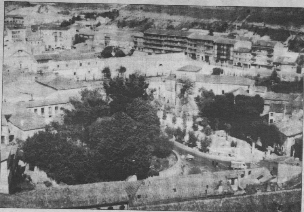
Para Cuéllar el cableado de alta tensión ya no será un factor de riesgo en el futuro.
