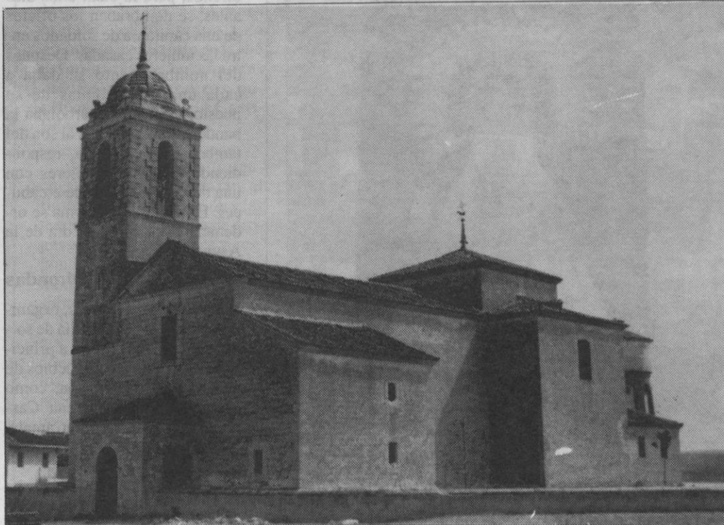
La iglesia parroquial de Nuestra Señora de la Asunción necesita múltiples reparaciones.
