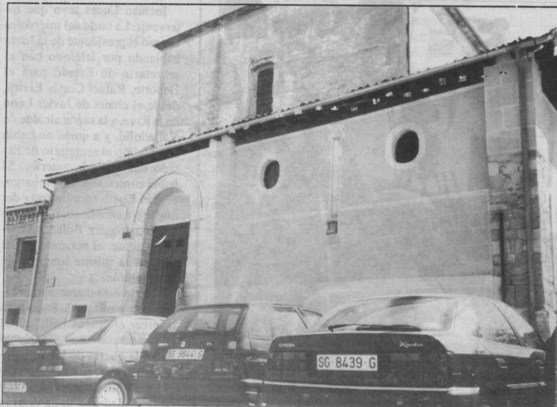
Las obras han consistido en limpiar la parte frontal, recuperar ventanas y resaltar columnas.
