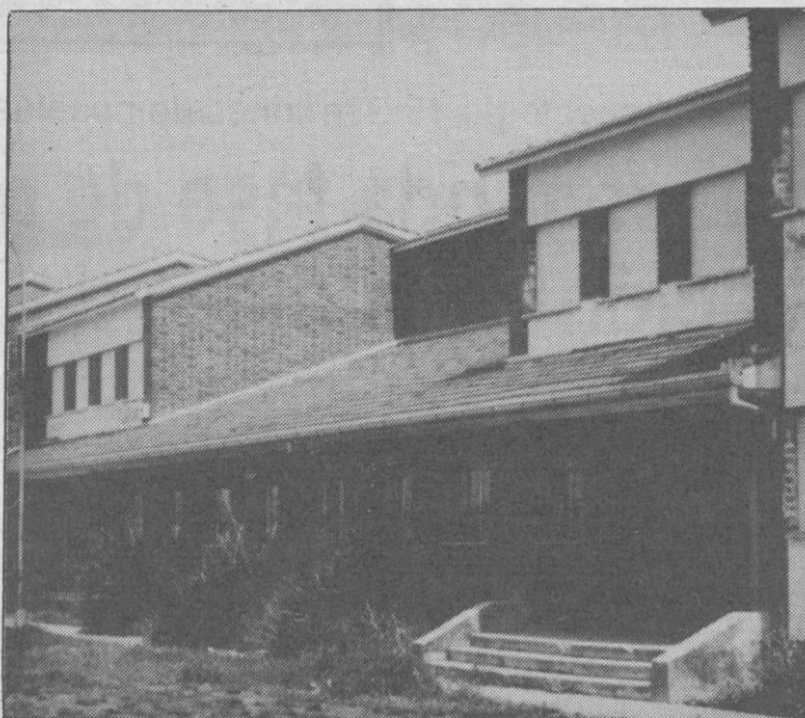
En el IB "Catalina de Lancaster" se reparó los zócalos.
