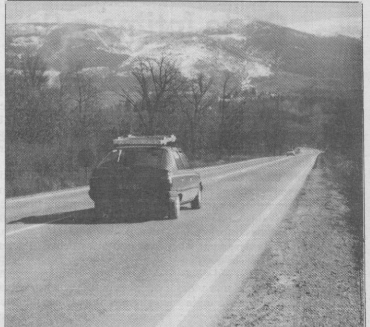
Las obras del desdoblamiento comenzarán en breve.
