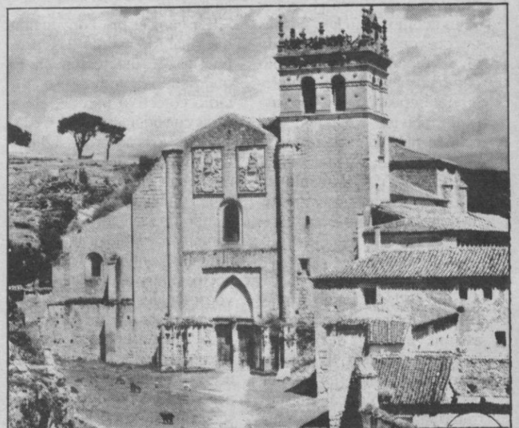
El Monasterio de El Parral, uno de los edificios más afectados.
