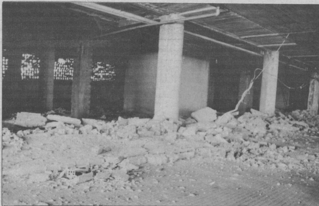
El aparcamiento de la estación de autobuses tendrá capacidad para 127 automóviles.
