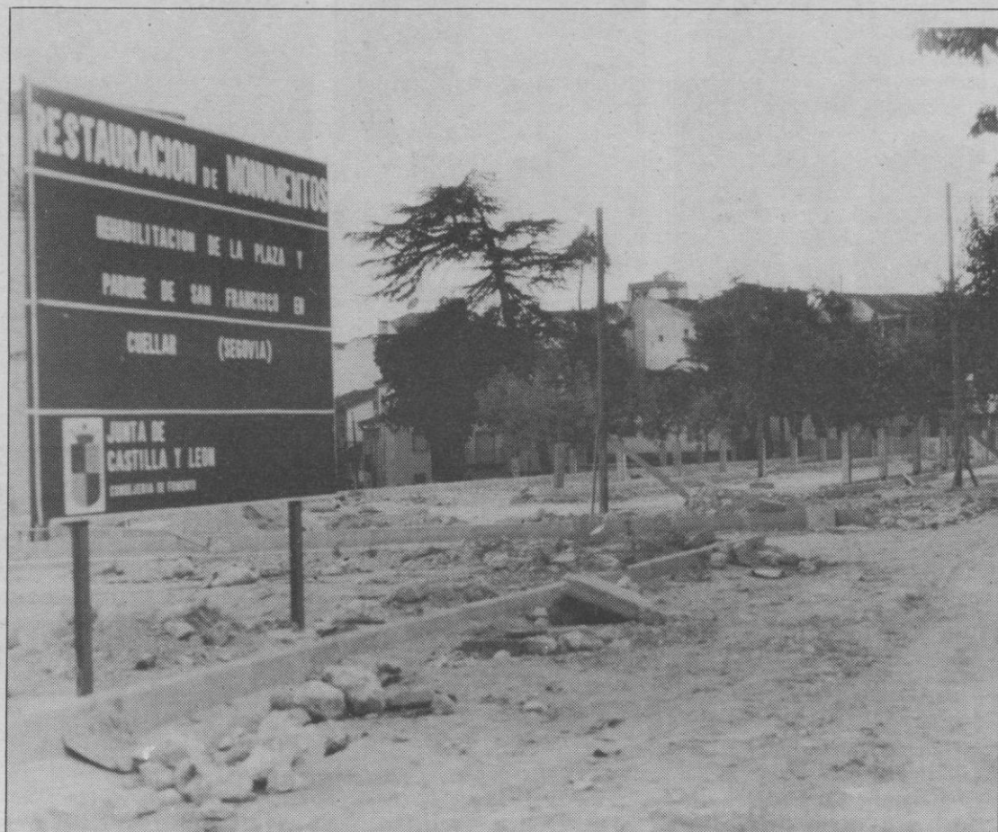
El paseo de San Francisco en Cuéllar, durante las obras.
