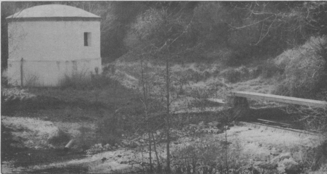
Zona de abastecimiento de agua en el río Cega.
