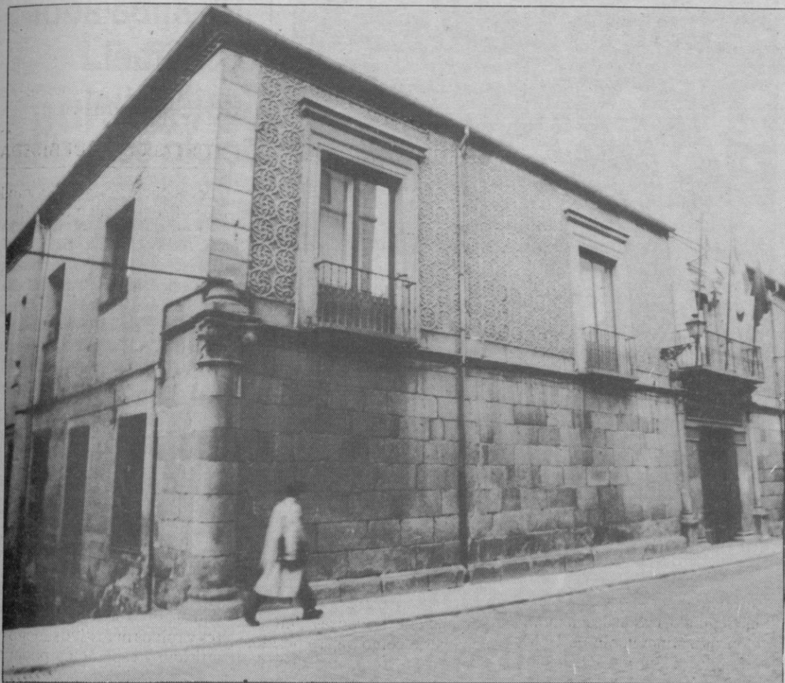
Fachada principal de la sede de la Diputación Provincial de Segovia.
