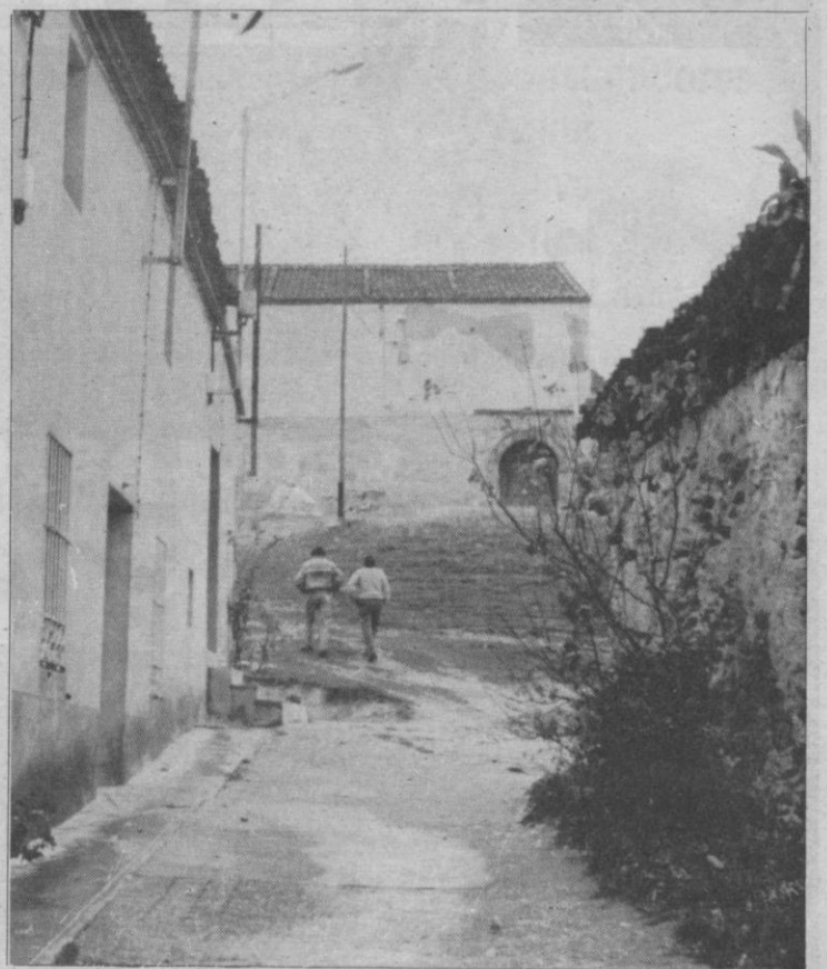
Las calles de Torredondo se encuentran sin asfaltar.
