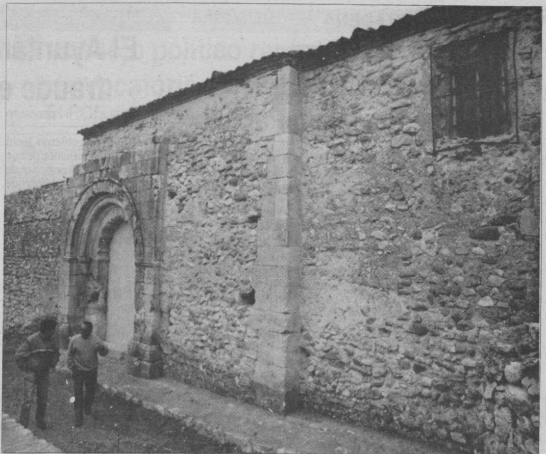
En la fachada sur de la iglesia hay una preciosa portada románica.
