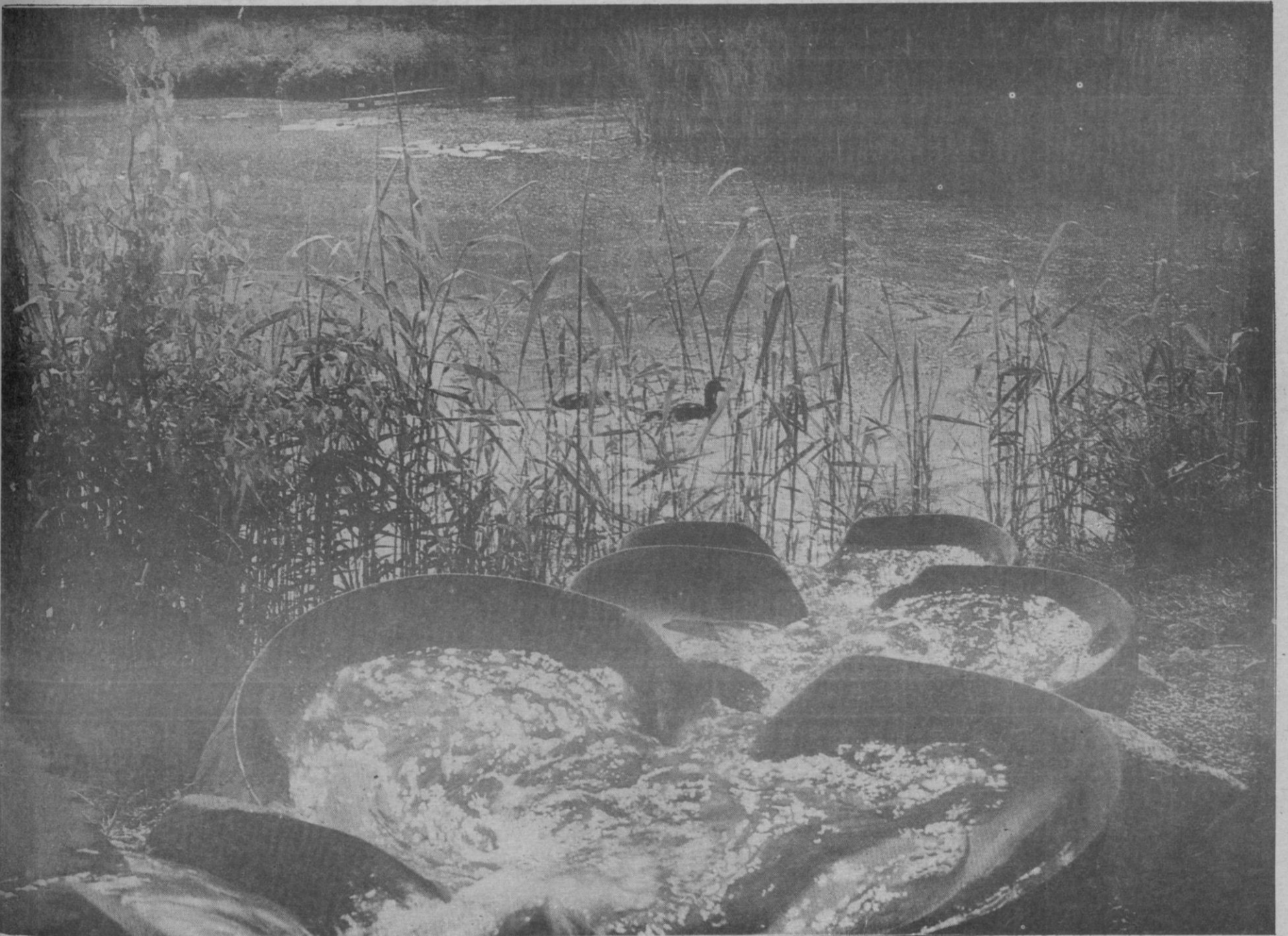
Cascada de formas de flujo de la depuradora de filtro verde instalada en Järna, Suecia
