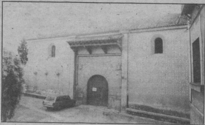
Las obras de rehabilitación de La Alhóndiga obliga a un traslado, en su interior, de los fondos del Archivo Municipal
