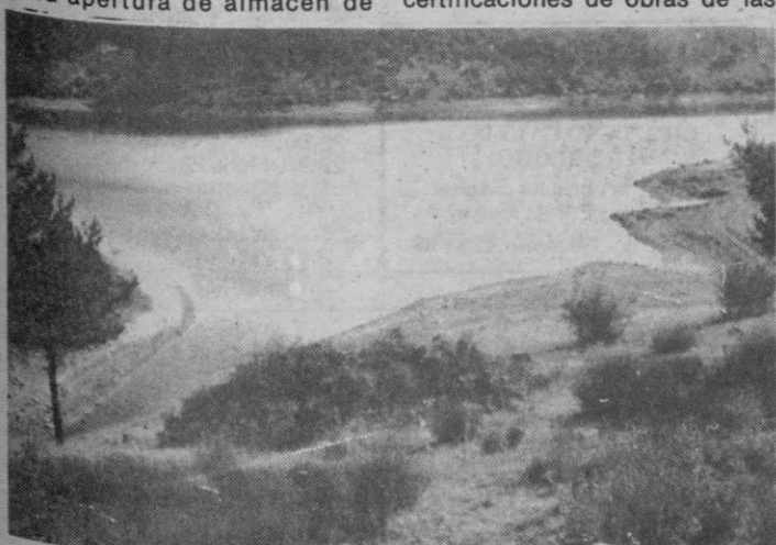
Puente Alta afectado por la prolongada sequía
