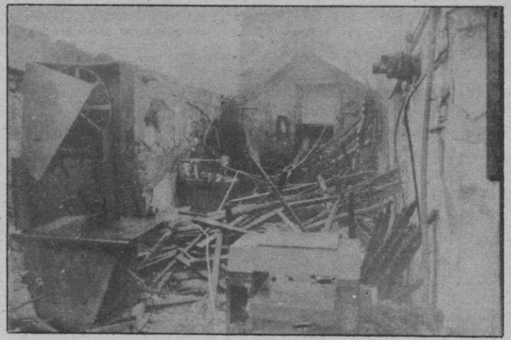
Estado en que quedó el taller, tras el incendio
