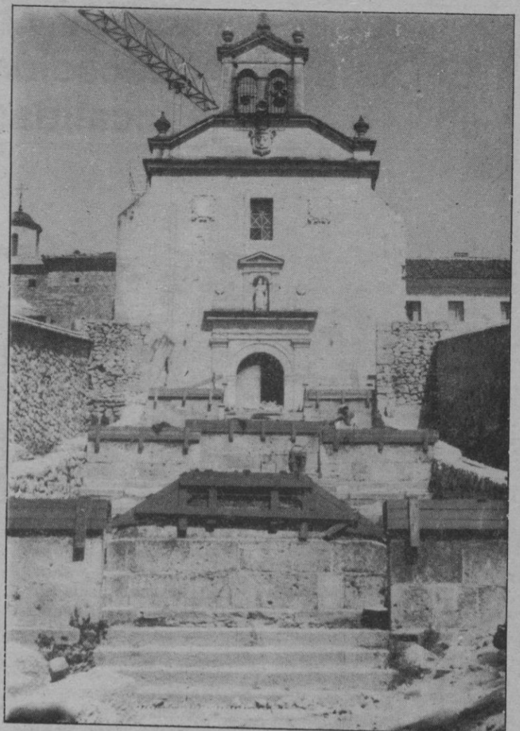
La subida a la iglesia en plena obra
